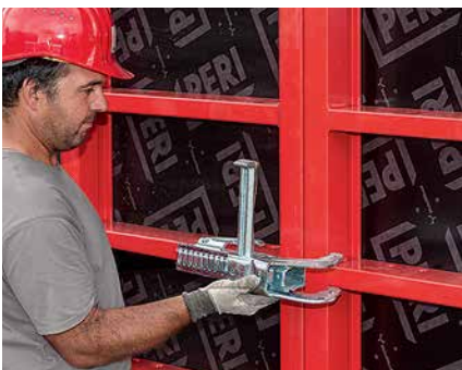
Das BFD Richtschloss lässt sich mit nur einer Hand bedienen.
