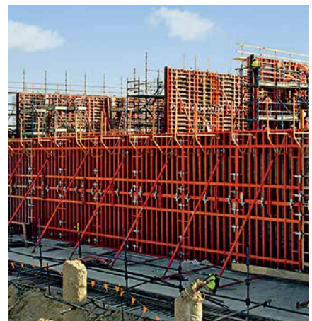
TRIO lässt sich bis 5,40 m Höhe im 30-cm-Raster aufstocken. Bei größeren Höhen wird zusätzlich ein Ausgleichsriegel eingesetzt.
