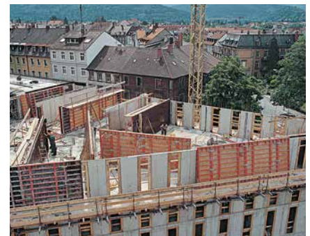
TRIO Struktur ist mit den TRIO Standardelementen kombinierbar. Dies ist von Vorteil, da spezielle Oberflächen häufig nur an einer Seite gefordert sind.
