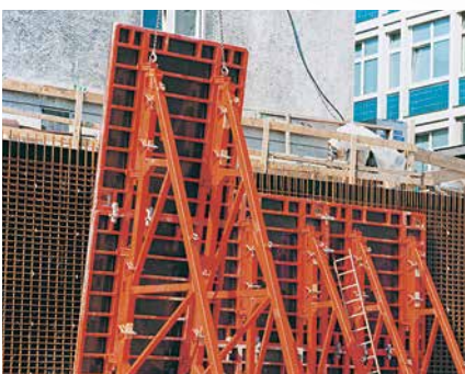
Kraftschlüssige Verbindung ermöglicht das Umsetzen als komplette Einheit.
