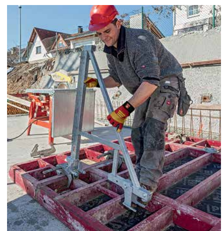
Die Arbeitsbühnen werden am Element der entsprechenden Breite montiert und verbleiben auch bei der Zwischenlagerung an der Schalung.
