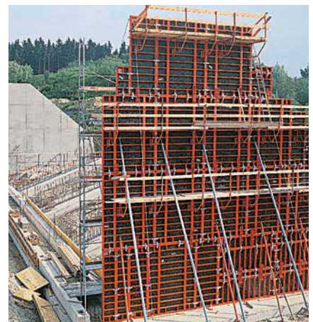
Mit TRIO 330 lassen sich sehr hohe Wände besonders schnell ausführen – mit nur 4 Elementen ergibt sich eine 13,20 m hohe Wand.
