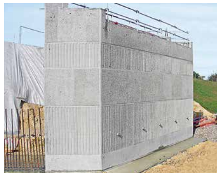
TRIO Struktur lässt sich mit unterschiedlichen Platten und Oberflächen belegen, das lässt großen Spielraum für die Gestaltung.
