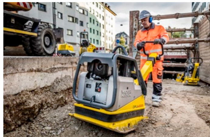
In jedem Fall sicher: Wird der Führungsbügel losgelassen, bewegt sich das Gerät nur noch auf der Stelle.
