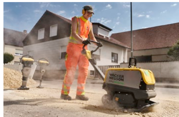
Mit einer Batterieladung verdichtet die APU3050e bis zu 333 m 2 Boden*.
