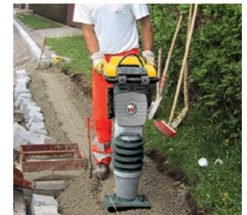
Exakte Geräteführung – wichtig bei der Verdichtung in Randbereichen.
