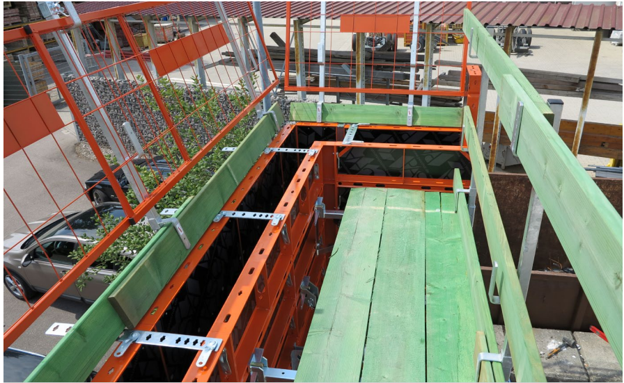
Zubehörteile und Verbindungsmittel der Universalschalung Raster/GE und der LOGO.3 können ebenfalls für die NeoR-Schalung verwendet werden.
