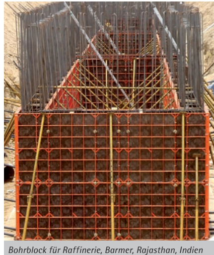
Bohrblock für Raffinerie, Barmer, Rajasthan, Indien
