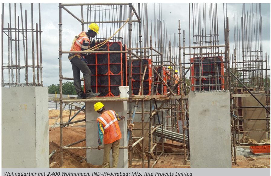
Wohnquartier mit 2.400 Wohnungen, IND-Hyderabad; M/S. Tata Projects Limited
