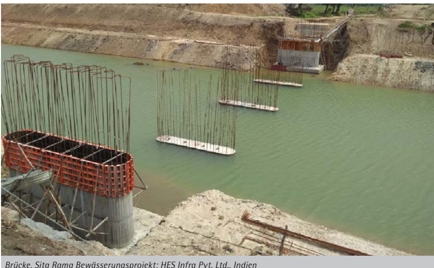
Brücke, Sita Rama Bewässerungsprojekt; HES Infra Pvt. Ltd., Indien
