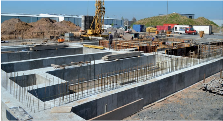
Neubau eines Bürogebäudes mit Lagerhalle, Gelnhausen; Grauel Hoch- u. Tiefbau GmbH & Co. KG, Birstein
