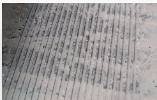
Rillenprofil in einer Betonfläche
