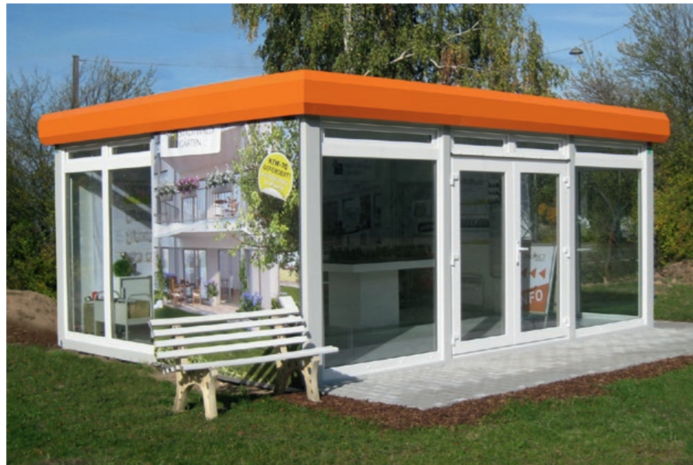
Doppelanlage als Schauraum
