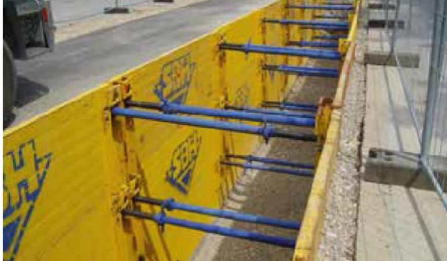
Werden größere Grabentiefen für Versorgungsleitungen, Hausanschlüsse oder im Kabelbau benötigt, ist das Verbausystem auch aufstockbar.
