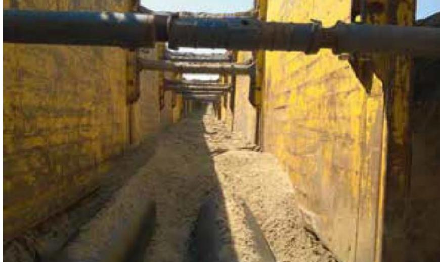
Die 300er Leichtbox ist für den kleinen bis mittleren Kanalverbau und den Einsatz leichter Baumaschinen geeignet. Die robuste Konstruktion ermöglicht gegenüber der 100er Serie höhere Rohrdurchlässe.
